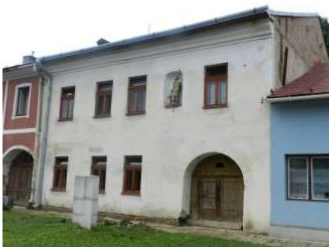
Dom so sochou sv. Floriána č. s. 114 (v rekonštrukcii)
